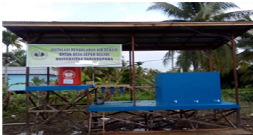
Gambar 2. Instalasi air bersih dengan sistem filtrasi
