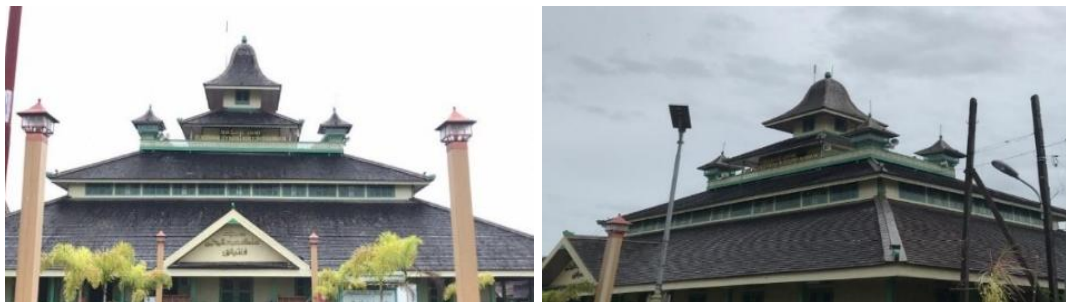
Gambar 8 . Foto Atap Masjid Jami' Sultan Syarif Abdurrahman (Sumber: Dokumentasi Penulis, foto diambil pada tanggal 6 September 2020)
