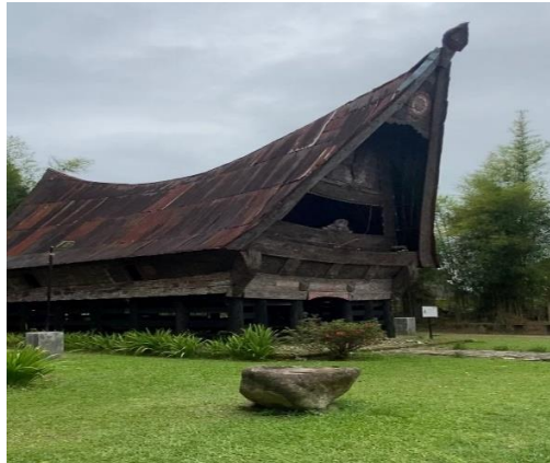
Gambar 1. Bagian atap rumah Bolon
