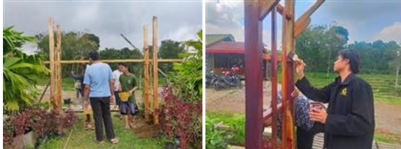
Gambar 7 Proses Pembangunan Gapura di Cafe Pondok Sawah
