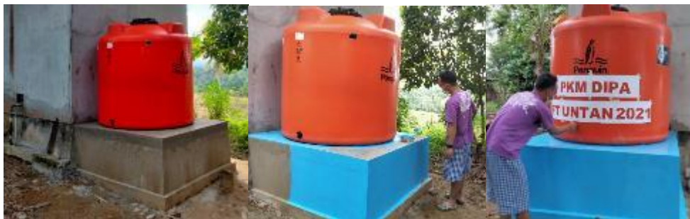
Gambar 5 (Kiri) Tandon Air Beserta Fondasi, (Tengah Dan Kanan) Proses Pengecatan
