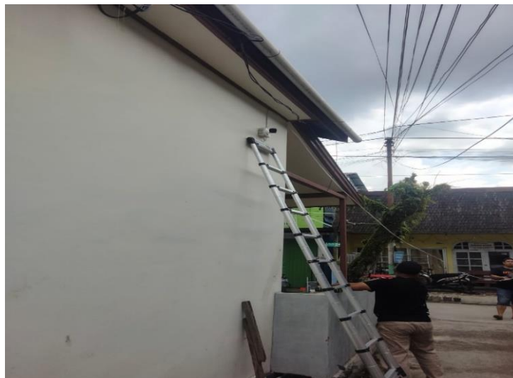
Gambar 2 Proses Pemasangan CCTV
