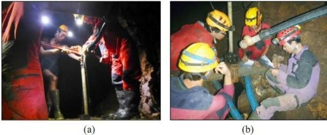
**Gambar 3. (a) pelepasan pompa submersible kapasitas 1,5 HP dan (b) pemasangan pompa submersible kapasitas 2 HP di dalam Goa Suruh (Dokumentasi Peneliti, 2014)**
