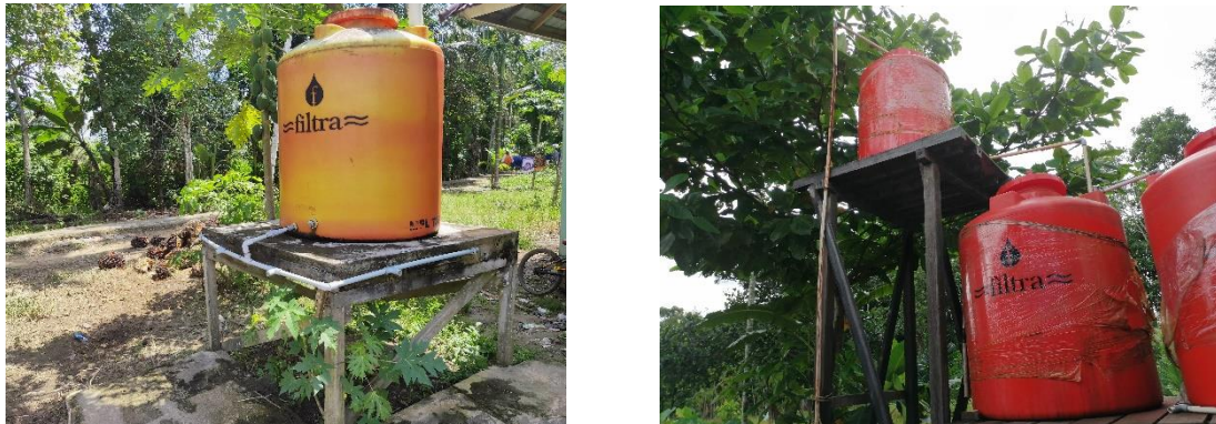
Gambar 6. (a) Penampungan air bersih SD Negeri 06 Rasau Jaya, (b) Penampungan air bersih SD Negeri 13 Rasau Jaya
