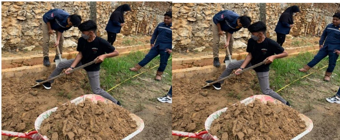
Gambar 5 Pembersihan Lokasi Pemasangan Biopori
