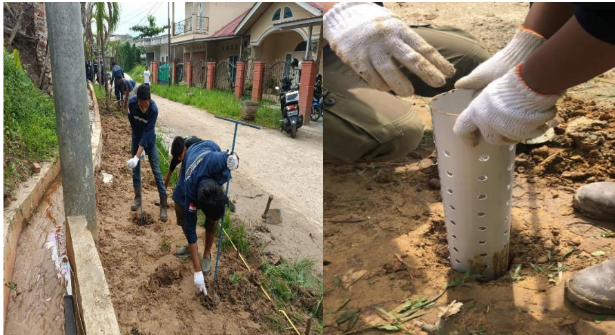
Gambar 6. Pengeboran Lubang dan Pemasangan Biopori
