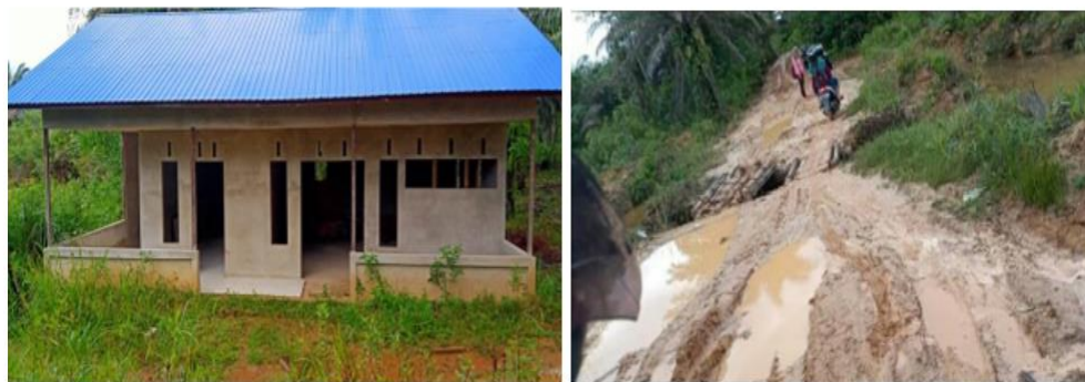
Gambar 1. Kondisi gedung TK dan akses jalan menuju Desa Nyiin
