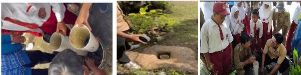
Gambar 3. Memasukan Sampah Organik Ke Pipa dan Pemasangan Pipa Ke Lubang Biopori
