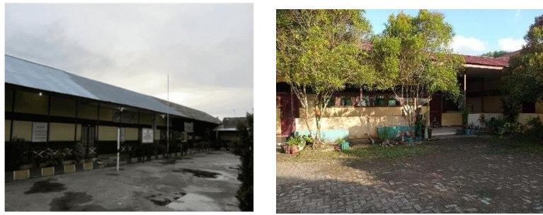
Gambar 1. Keadaan SDN 39 Sungai Raya Sebelum Kegiatan Pemasangan Paralon Pada Lubang Biopori
